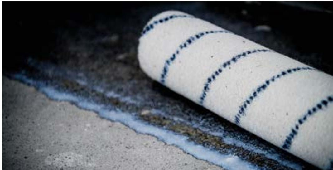
Grundierungen, oder auch Primer, übernehmen viele wichtige Funktionen beim Fußbodenaufbau. Vorrangig sorgen sie dafür, dass Spachtelmassen und Klebstoffe optimal auf dem Boden haften. Auf glatten, dichten Untergründen bilden sie eine Haftbrücke, verbessern also die Benetzungsfähigkeit. Auf stark saugenden Untergründen vermindern sie die Saugfähigkeit. Beides reduziert den Verbrauch von Klebstoff oder Spachtelmasse. Das spart Zeit und Geld.
